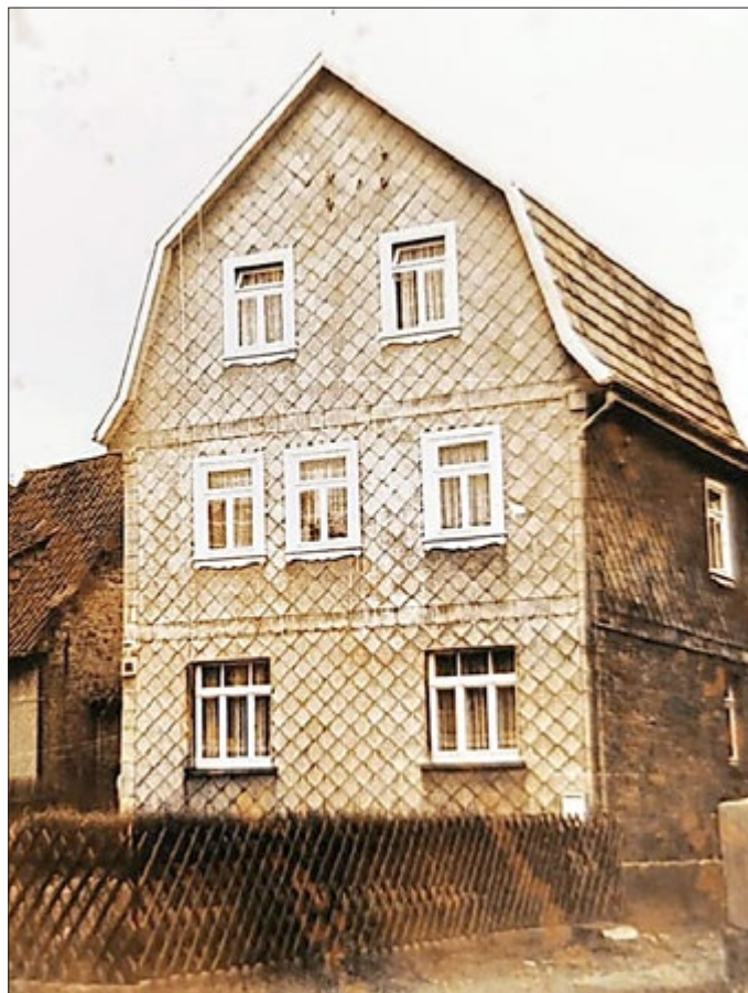
Die Eulenburg vor der Restaurierung
