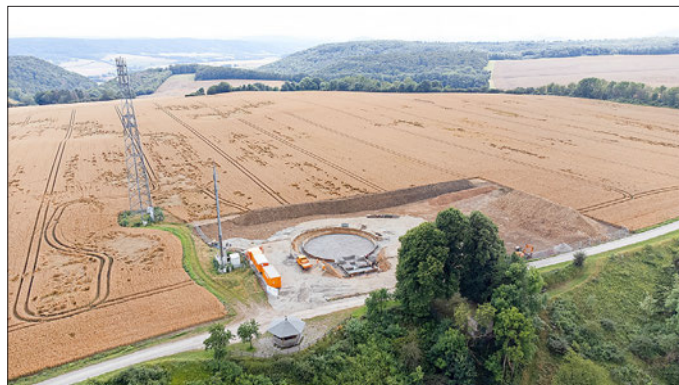
Arbeiten auf Hochtouren: Seit Februar lief die Planungsphase nun ist bereits das Fundament für den neuen Hochbehälter bei Kalteneber zu sehen.
