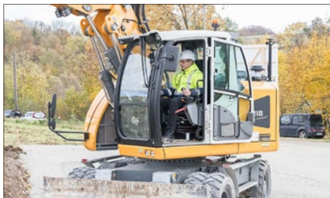
Offizieller Startschuss: Dingelstädt's Bürgermeister Andreas Fernkorn vollzog den ersten Spatenstich
