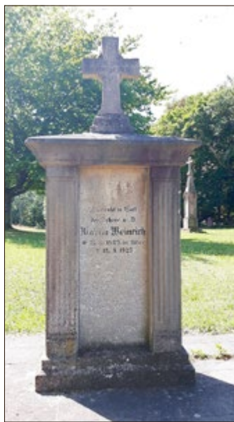
Vordere Ansicht vor der Sanierung
