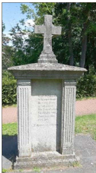
Rückansicht vor der Sanierung
