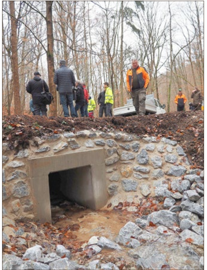
Projektbeteiligte begutachten den renaturierten Bachabschnitt
